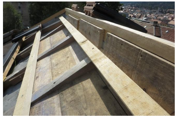
Pose de bois brut de sciage au niveau du faîte, réduisant l'espace de ventilation
