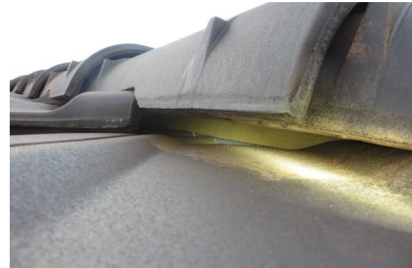
Espace d'accès par les tuiles faitières et/ou arêtières de 1.5 à 2 cm
