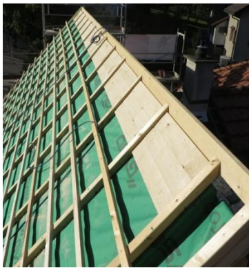
Pose de bois brut de sciage au niveau du faîte, réduisant l'espace de ventilation
