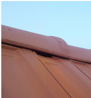
Espace d'accès par les tuiles faitières et/ou arêtières de 1.5 à 2 cm
